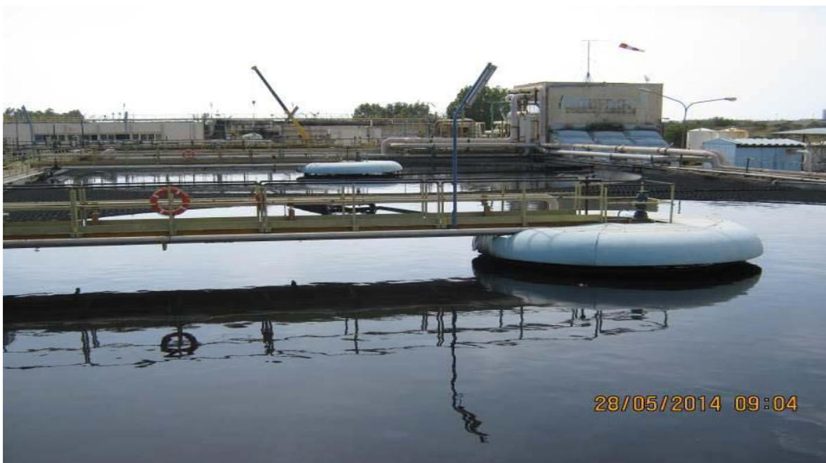
Le 4 vasche sono in cemento armato, non interrate, a pianta circolare con meccanismo raschiafango a due bracci al centro di ogni vasca.
